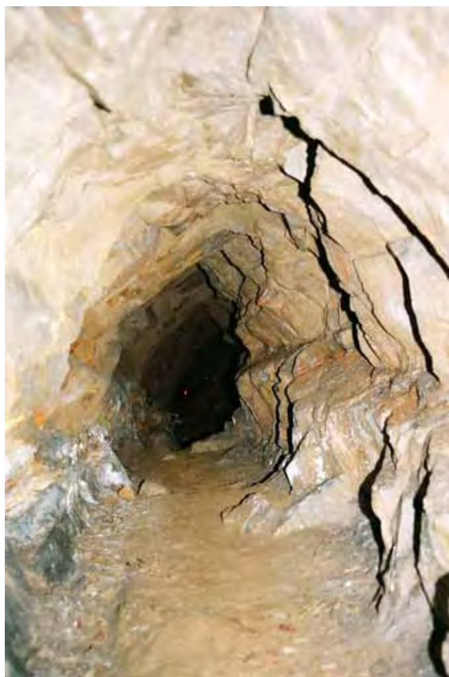
Fig. 13. Sztolnia w Jarmucie, korytarz górnego poziomu, fot. T. Kuś • The Jarmuta adit, the upper level of the tunnel, phot. T. Kuś
