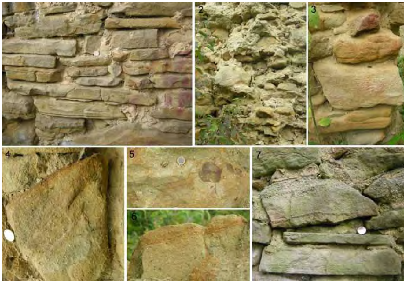
Fig. 17. Piaskowce istebniańskie w murach ruin zamku rycerskiego Rożnów zbudowanego na wychodniach piaskowców istebniańskich dolnych, fot. A. Waškowska. 1 – fragment muru zbudowany z drobno- i średnioziarnistych piaskowców płytowych z zachowaną laminacją równoległą, a miejscami i przekątną (na lewo od monety 1 €); 2 – fragment muru z nieregularnych fragmentów łamanego piaskowca; 3 – fragmenty gruboławicowych gruboziarnistych i zlepieńcowatych piaskowców z słabo zaznaczoną laminacją; 4 – gruboziarnisty piaskowiec z laminacją przekątną; 5 – piaskowiec gruboziarnisty z klastami piaskowców o spoiwie krzemionkowo-żelazistym; 6 – piaskowiec zlepieńcowaty z żelazistymi pierścieniami wietrzennymi Lieseganga; 7 – gruboziarnisty piaskowiec frakcjonalnie uziarniony ze słabo widoczną laminacją (nad monetą) i piaskowce płytowe poniżej.
