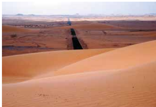
Fig. 3. Wędrujące wały wydymowe przecinające drogę koło El Kharga • Shifting sand dunes cross the road near El-Kharga
