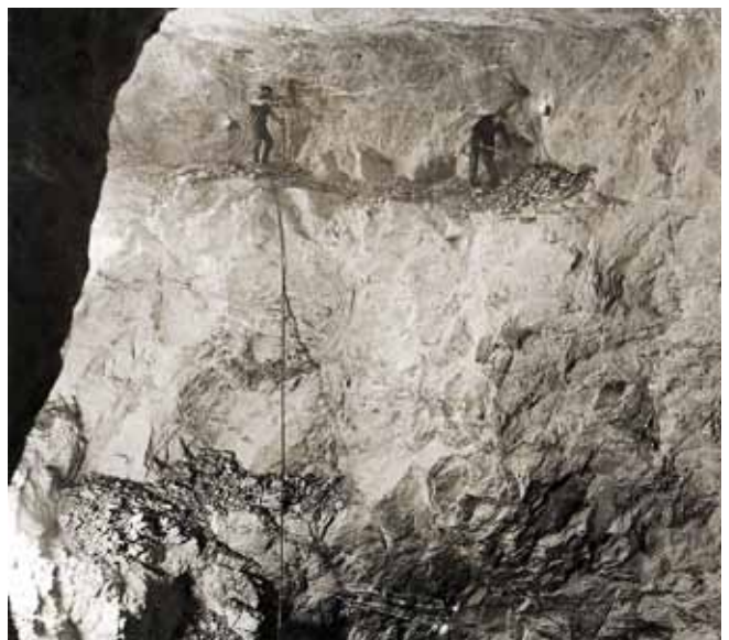
Fig. 12. Reconstructed chamber in the Stebnyk mine. Photo from private archive of Prof. J. Poborski • Kopalnia Stebnyk – komora w odbudowie. Fot. z prywatnego archiwum prof. J. Poborskiego
