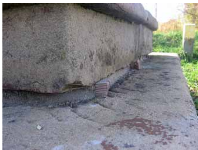
Fig. 20. Bloki kamienne połączone zaprawą wspomaganą drewnem, fot. M. Schuster • Stone blocks joined with cement and wood pegs, phot. M. Schuster
