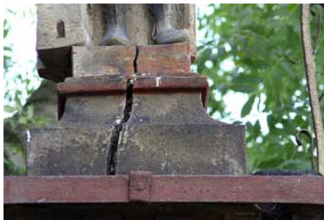
Fig. 16. Spękana dolna część figury kapliczki w Wieliczce, fot. M. Schuster • The cracked lower part of a figure from a wayside shrine in Wieliczka, phot. M. Schuster
