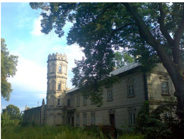
Fig. 12. The Reszke Palace in Kłobukowice, phot. O. Wolski • Pałac Reszków w Kłobukowicach, fot. O. Wolski
