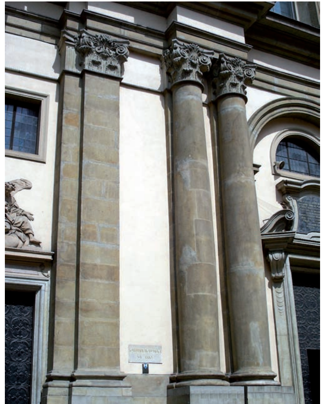
Fig. 3. The SE façade of the church – the plinth made of the Istebna Sandstone ashlars, the stars cut of the Cretaceous Quader Sandstone, phot. M. Florczyk • Elewacja SE kościoła – cokół z ciosów piaskowca istebniańskiego, schody z kredowego piaskowca ciosowego, fot. M. Florczyk
