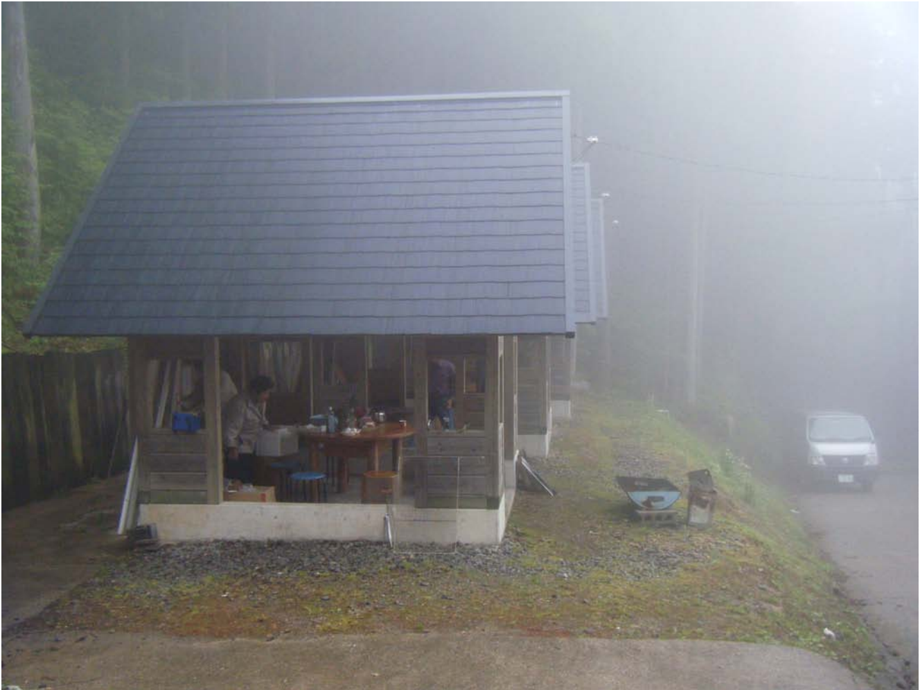
Fig. 14. Tourist station (Finnish-style estate) and ski centre on top Mt. Tsuguri (Sikoku), phot. U. Myga-Piątek • Stacja turystyczna (osada fińskich domków) i centrum narciarskie na szczycie Gór Tsuguri, fot. U. Myga-Piątek
