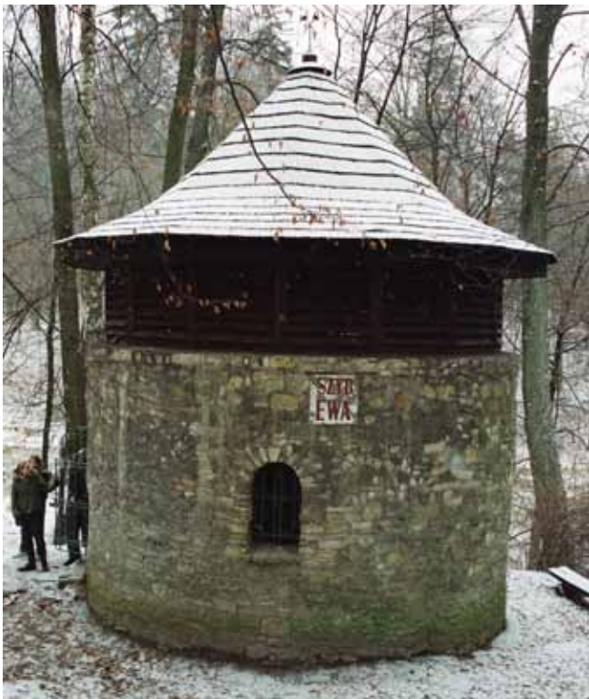
Fig. 12. Szyb „Ewa” sztolni „Czarnego Pstrąga” w Tarnowskich Górach, fot. M. Dzięgiel • The “Eve” shaft of the “Black Trout Adit” in Tarnowskie Góry, phot. M. Dzięgiel
