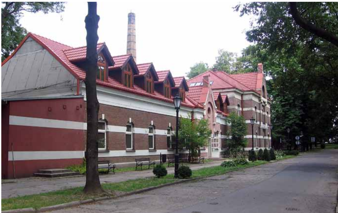
Fig. 16. Day Spa Relax Care in Cracow, phot. I. Jamorska • Ośrodek Day Spa Relax Care w Krakowie, fot. I. Jamorska
