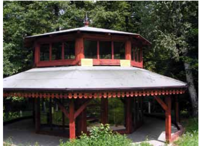
Fig. 3. The Main Spring – Swoszowice, phot. I. Jamorska • Źródło Główne – Swoszowice, fot. I. Jamorska
