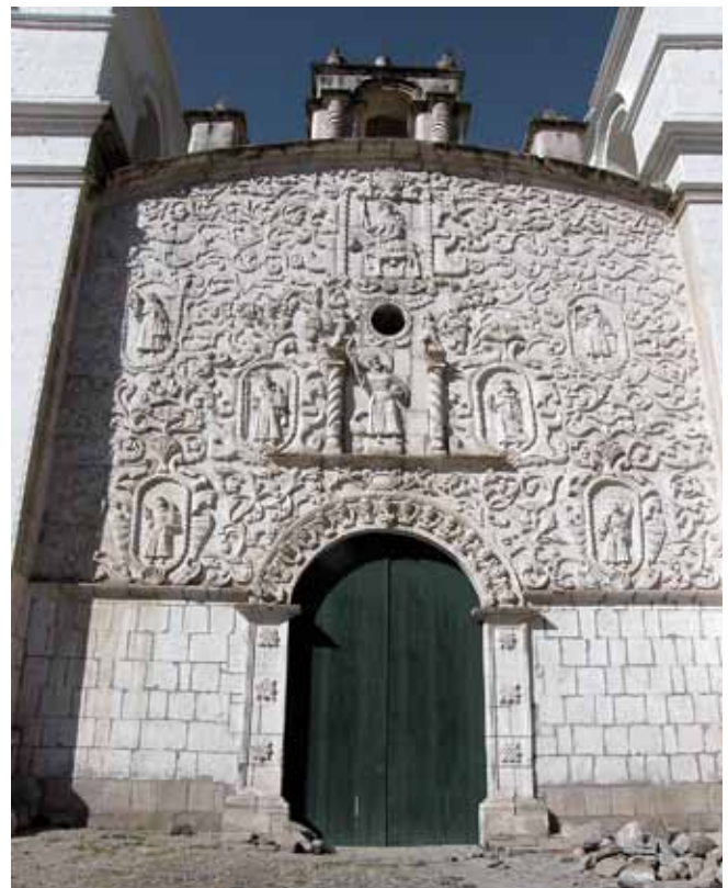
Fig. 12. A stone Immaculate Conception church in Yanque with the rich sculptured colonial baroque facade, phot. B. Radwanek-Bąk • Kamienny kościół w Yanque z bogato zdobioną, rzeźbioną fasadą w stylu kolonialnego baroku, fot. B. Radwanek-Bąk
