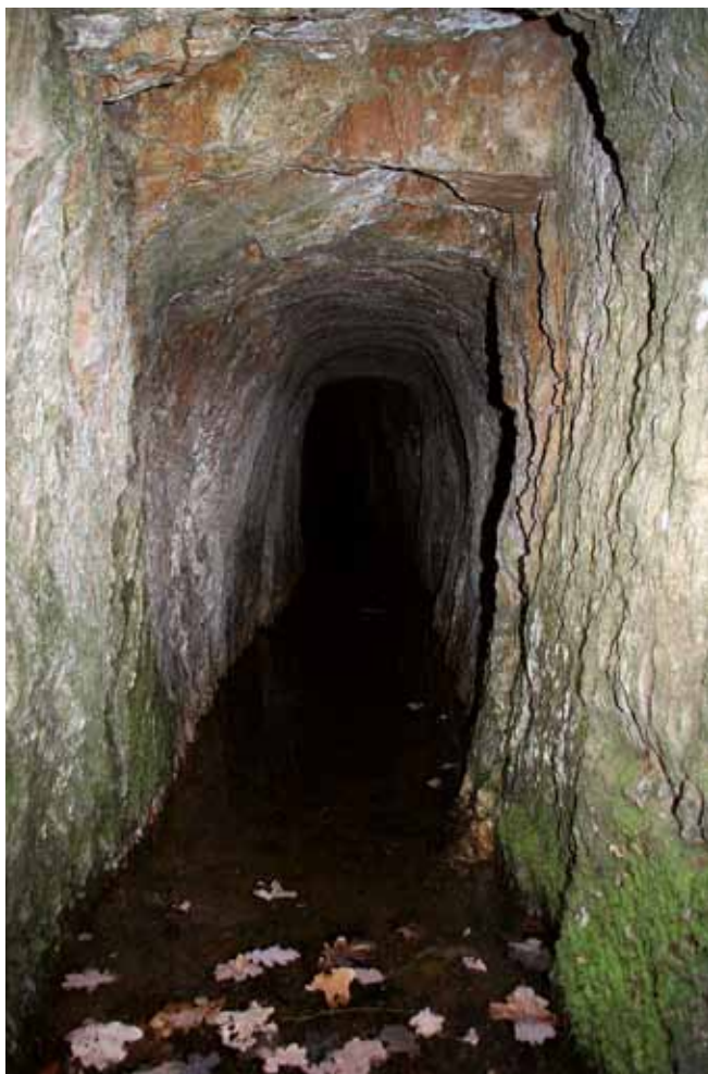
Fig. 16. Wejście do zalanej sztolni kopalni kobaltu Trzech Braci (niem., Drei Brüder) pomiędzy Gierczynem, a Przecznicą (OGT 5), fot. M. Łodziński • Entrance to flooded Three Brothers (niem., Drei Brüder) adit between Gierczyn and Przecznicia (OGT 5), phot. M. Łodziński
