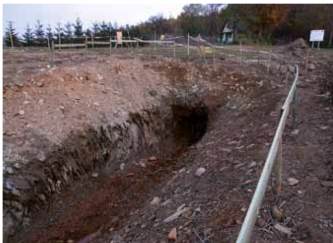
Fig. 13. Wylot sztolni odwadniającej Leopold na prawym brzegu Potoku Krobickiego w Kotlinie, odsłonięty w ramach prac udostępniających trasę geoturystyczną, fot. W. Mayer • Entrance to the Leopold drainage adit in the right bank of the Krobicki Stream in Kotlina exposed during the development of underground tourist trail, phot. W. Mayer
