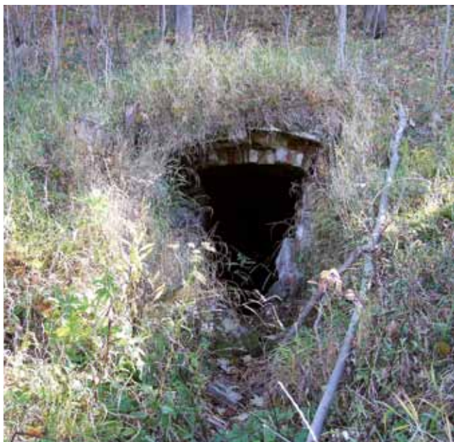
Fig. 33. Wejście do doskonale zachowanej sztolni przy bramie Zakładów Przemysłowych R-1 w Kowarach-Podgórzu, fot. W. Mayer • Entrance to perfectly preserved adit at the gate to the R-1 Industrial Plant in Kowary-Podgórze, phot. W. Mayer
