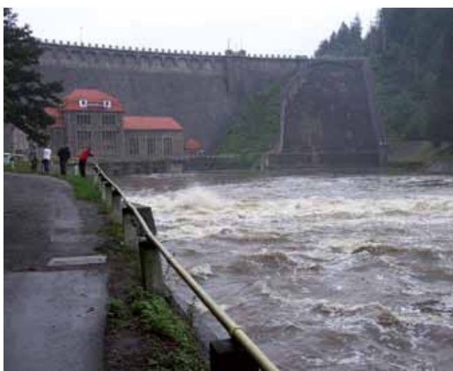
Fig. 19. Tama w Pilchowicach (OGT 7) posadowiona jest w przełomowej gardzieli gnejsowej rzeki Bóbr, fot. W. Mayer • The Pilchowice dam (OGT 7) founded at the Bóbr River water gap incised in gneisses, phot. W. Mayer
