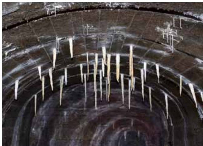
Fig. 35. Stalaktyty rozwinięte na obudowie betonowej w podziemnej trasie turystycznej Sztolnie Kowary, w sztolni szkoleniowej nr 9 (OGT 16), fot. M. Łodziński • Stalactites growing from the concret lining of No. 9 adit, the Kowary Adits underground tourist trail (OGT 16), phot. M. Łodziński
