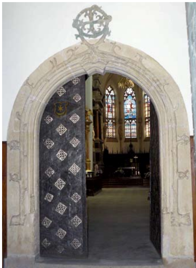
Fig. 18. Zachodni portal wejściowy do Katedry w kruchcie pod wieżą wykonany z piaskowca liasowego z Szydłowca, fot. B. Wójcik • The western inner portal in the narthex under the tower made of the Liassic Szydłowiec sandstone, phot. B. Wójcik).
