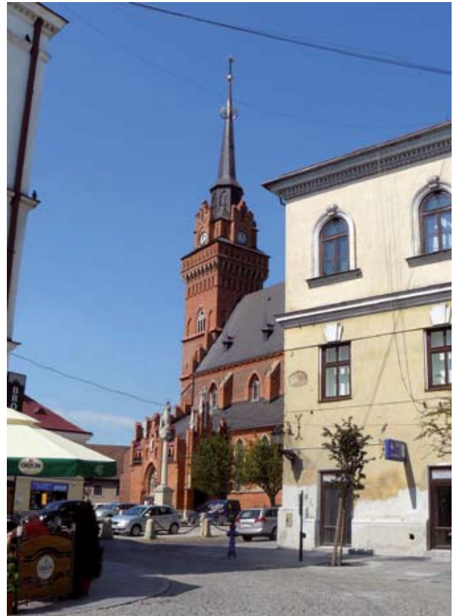
Fig. 1. Widok Kolegiaty od strony południowo-wschodniej, fot. B. Wójcik • A south-west view of the Cathedral, phot. B. Wójcik
