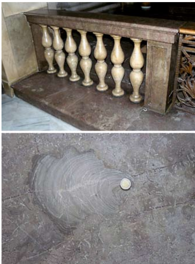
Fig. 8. Balustrada z tralkami i posadzka w części ołtarzowej nawy południowej wykonane z wapieni kieleckich (a), gałązkowate amfipory oraz kuliste duże stromatopory (b), fot. B. Wójcik • The railing with banisters and the floor made of Kielce limestone (a) in the altar part of the southern aisle; twig-like amphipora and large, spherical stromatopora (b), phot. B. Wójcik
