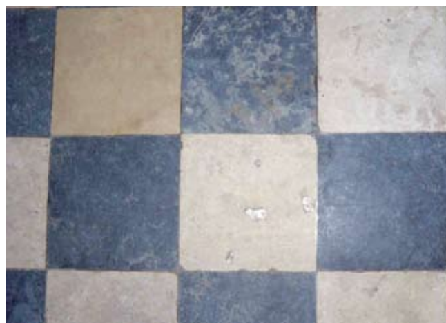
Fig. 14. Posadzka wykonana z czarnego gruzłowatego wapienia dębnickiego i jasno-kremowego wapienia morawickiego, fot. B. Wójcik • The floor made of the black nodular Dębnik limestone and the light creamy Morawica limestone, phot. B. Wójcik
