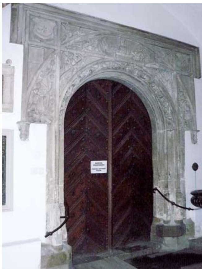
Fig. 4. Portal wykonany z wapienia pińczowskiego, kropielnica z marmuru dębnickiego oraz granitowa posadzka w przedśionku południowych Katedry, fot. B. Wójcik • The portal made of the Pińczów limestone, holy-water basin made of the Dębnik marble, and the granite floor in the southern porch, phot. B. Wójcik
