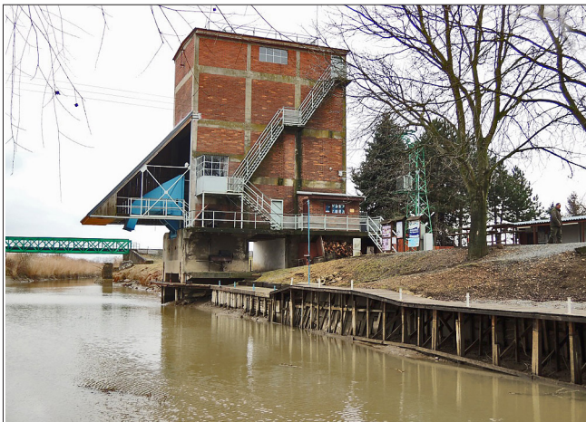
Fig. 8. Technical monuments - tilted lignite dispenser on Baťa Canal, photo M. Klempa • Zabytek techniki – podnoszony dozownik węgla brunatnego na Kanale Baťa, fot. M. Klempa
