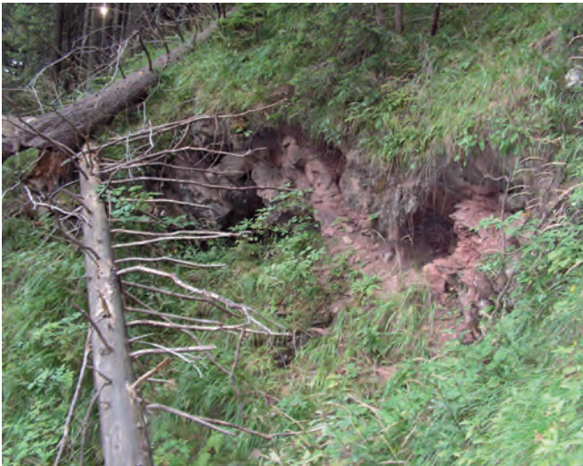
Fig. 9. The Huciańskie Banie 5 adit – view from the outside, phot. A. Ziemianek • Sztolnia Huciańskie Banie 5 – widok z zewnątrz, fot. A. Ziemianek
