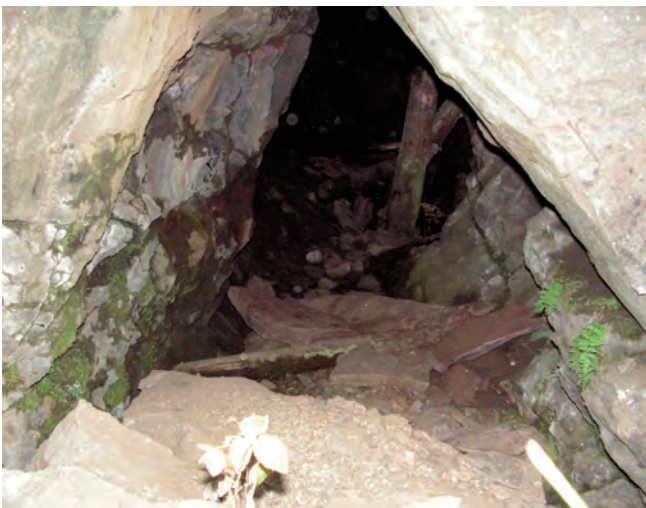
Fig. 10. The Huciańskie Banie 5 adit – mine corridor, phot. A. Ziemianek • Sztolnia Huciańskie Banie 5 – wnętrze sztolni, fot. A. Ziemianek
