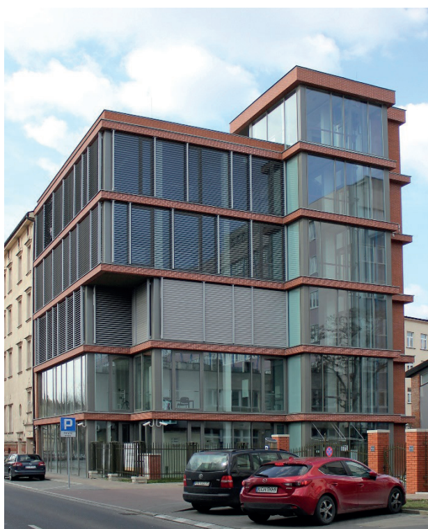
Rys. 1. Budynek Małopolskiego Laboratorium Budownictwa Energooszczędnego Politechniki Krakowskiej
