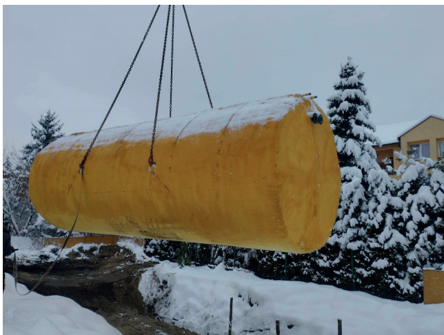
Rys. 5. Podziemny magazyn energii cieplnej o objętości 50 m 3 opracowany przez firmę Czamara Energia Odnawialna
