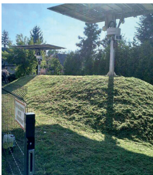
Rys. 3. Trackery PV-T firmy ELFRAN zainstalowane w Krakowie
