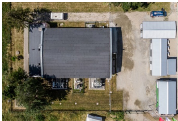
Rys. 4. Widok z góry na magazyn energii (po prawej) położony obok podstacji trakcyjnej Garbce (po lewej) (źródło: materiały PKP Energetyka S.A.)
